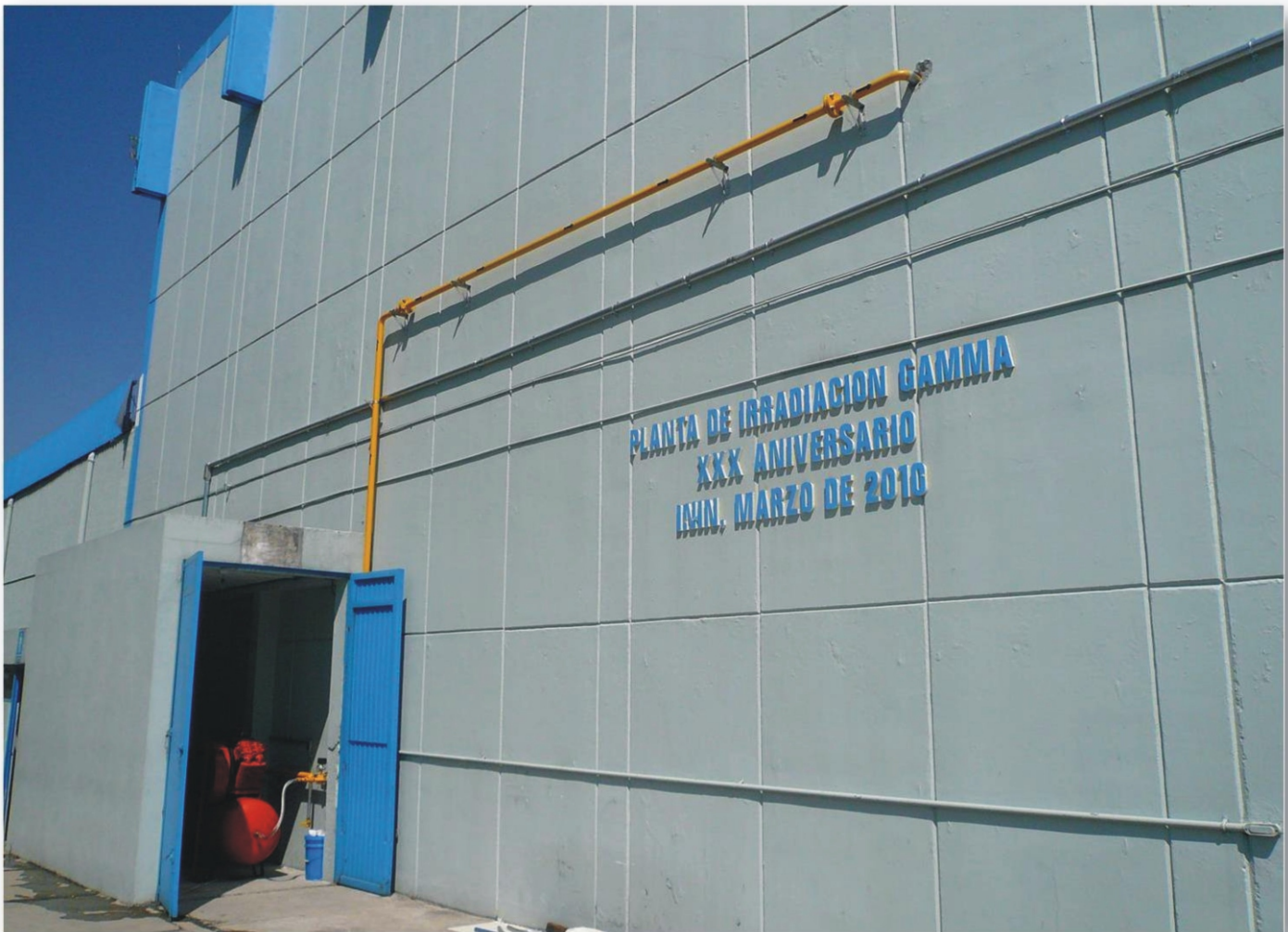
Modernización del Sistema de Aire Comprimido
